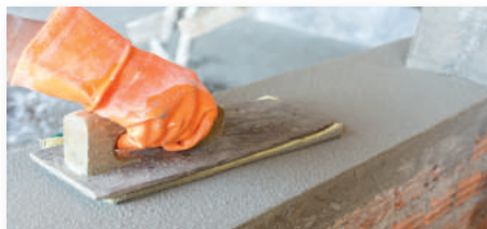
Morteros de reparación
