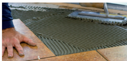
Encolado de azulejos
