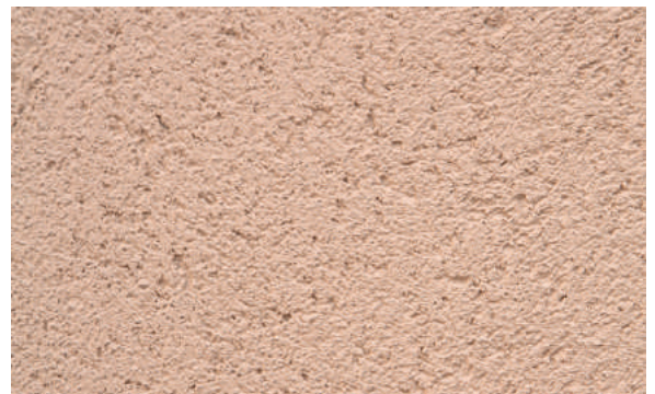
10. Acabado final del PX-28 Isolxtrem SILOXANE TECHNOLOGY G.
