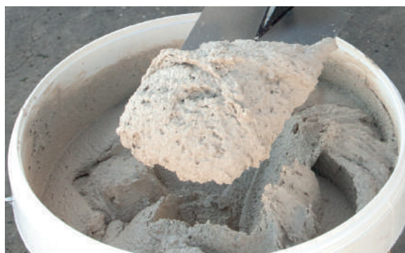
2. Extraer el PX-28 Isolxtrem SILOXANE TECHNOLOGY L con la ayuda de una paleta.
