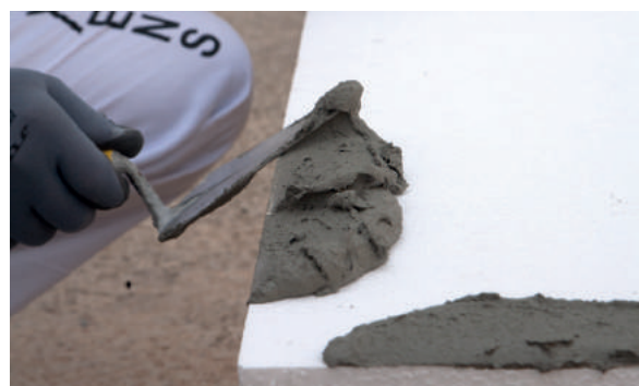
4. Aplicación del CX-28 Isolxtrem Poliestirex sobre EPS
