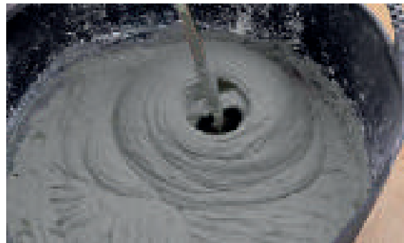
2. Amasado del CX-28 Isolxtrem Poliestirex
