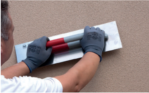
5. Alisar el PX-28 Isolxtrem SILOXANE TECHNOLOGY G.
