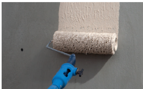
Aplicación sobre CX-28 Isolxtrem Poliestirex
