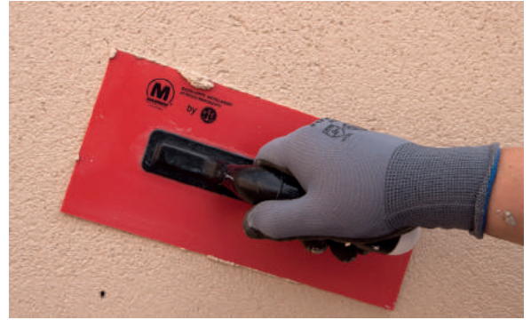
6. Fratar el PX-28 Isolxtrem SILOXANE TECHNOLOGY G.
