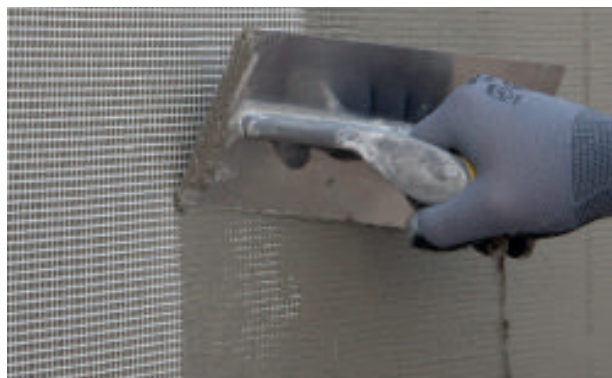
11. Colocación de la malla de refuerzo
