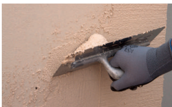
4. Aplicar PX-28 Isolxtrem SILOXANE TECHNOLOGY L sobre el soporte.
