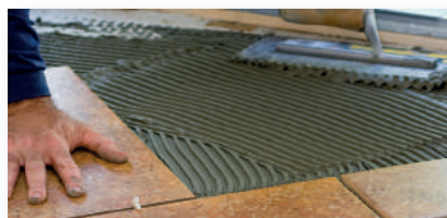
Encolado de azulejos
