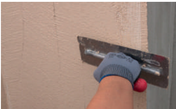
9. Alisar el PX-28 Isolxtrem SILOXANE TECHNOLOGY G depositado sobre la malla.
