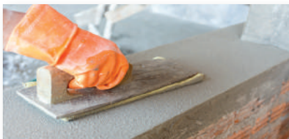
Morteros de reparación
