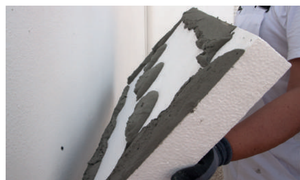
6. Colocacion de la placa sobre el soporte
