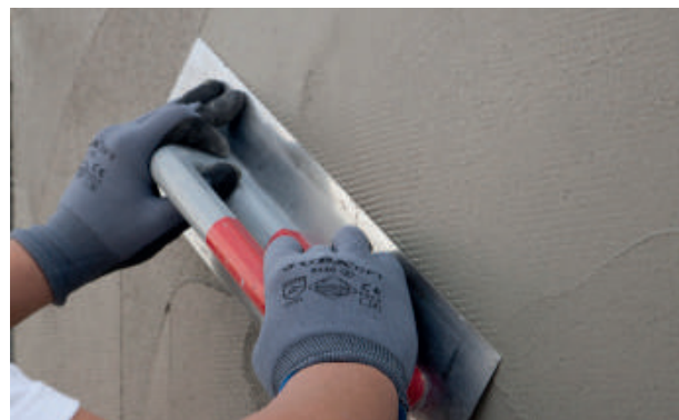
12. Enlucido sobre la malla de refuerzo
