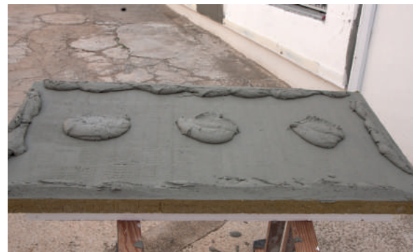
8. Encolado de placa de lana de roca
